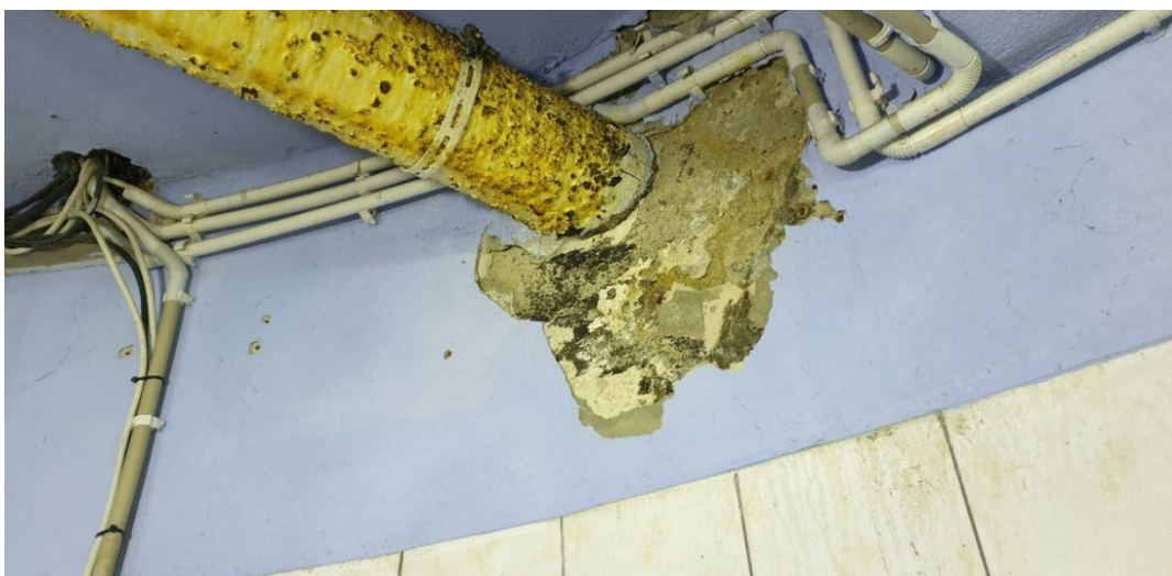
Fot. 10. Widok wnętrza przepompowni – poziom dolny, uszkodzenia powłoki malarskiej
