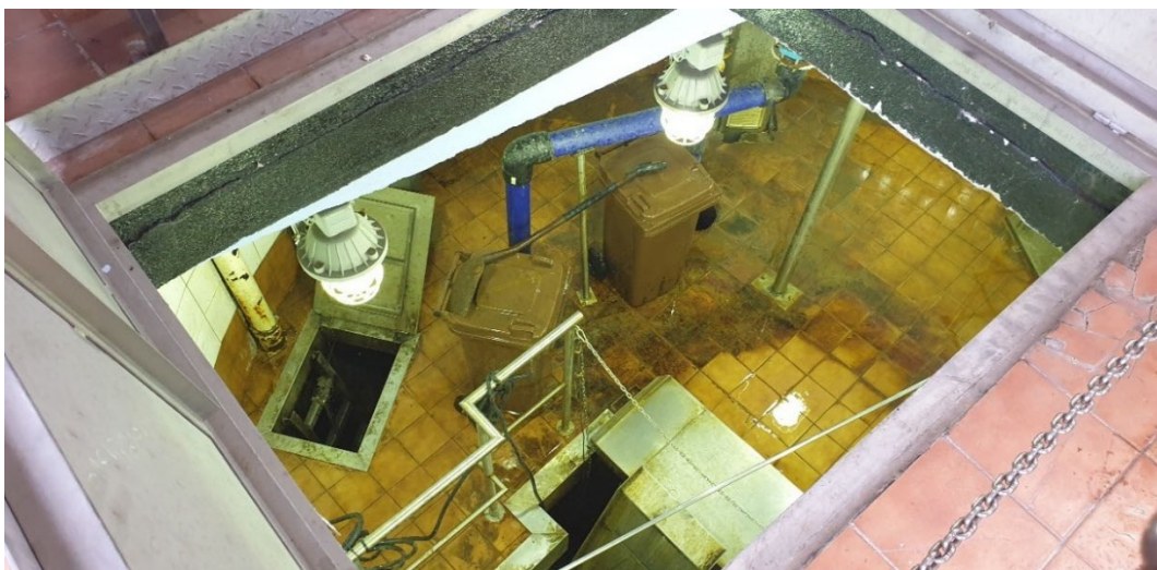
Fot. 8. Luk technologiczny – widok poziomu dolnego i systemu odbioru skrętek w komorze cerpальной
