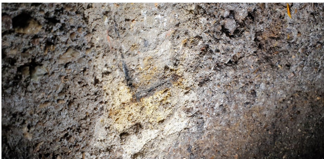
Fot. 25. Widok produktów korozji siarczanowej, punktowa odkrywka betonu
