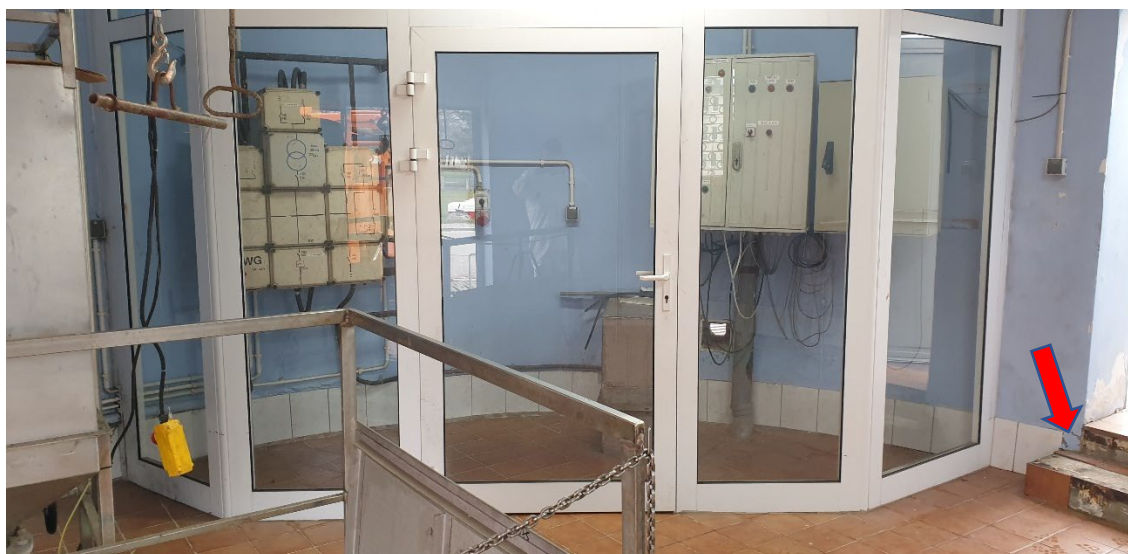
Fot. 7. Wnętrze przepompowni – poziom górny, pomieszczenie sterownicze, uszkodzenia okładziny stopni
