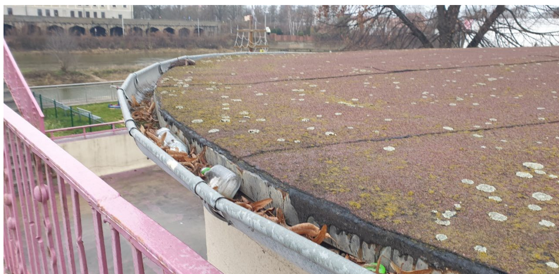
Fot. 3. Korozja obróbek blacharskich, zużycie pokrycia dachowego
