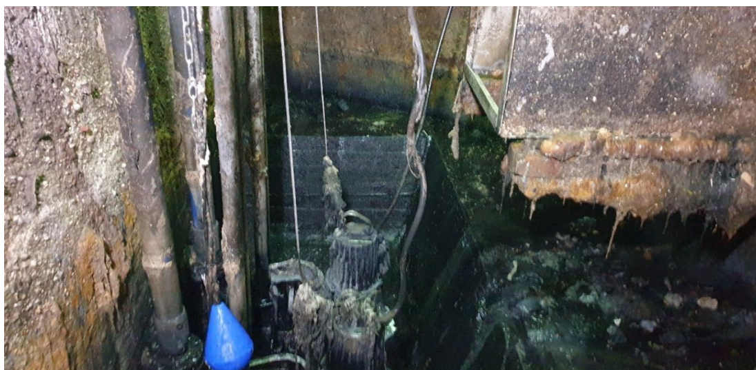
Fot. 21. Wlot kanału do komory czepalnej I
