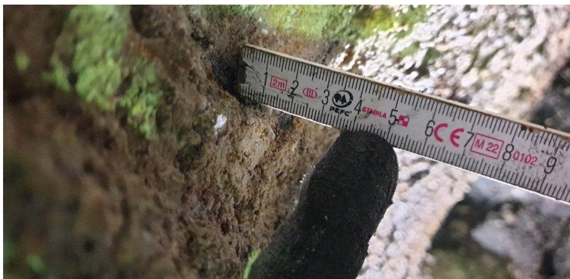
Fot. 24. Ubytki betonu rzędu 40mm na ścianie komory czepalnej
