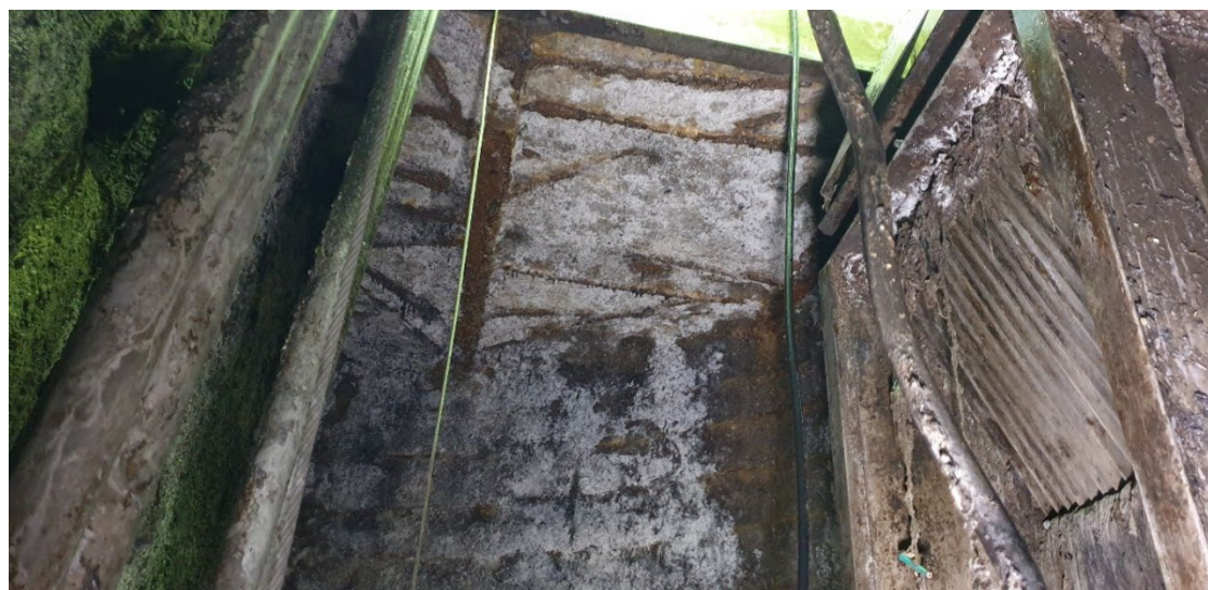
Fot. 27. Widok korozji betonu i elementów stalowych na stropie komory czepalnej I
