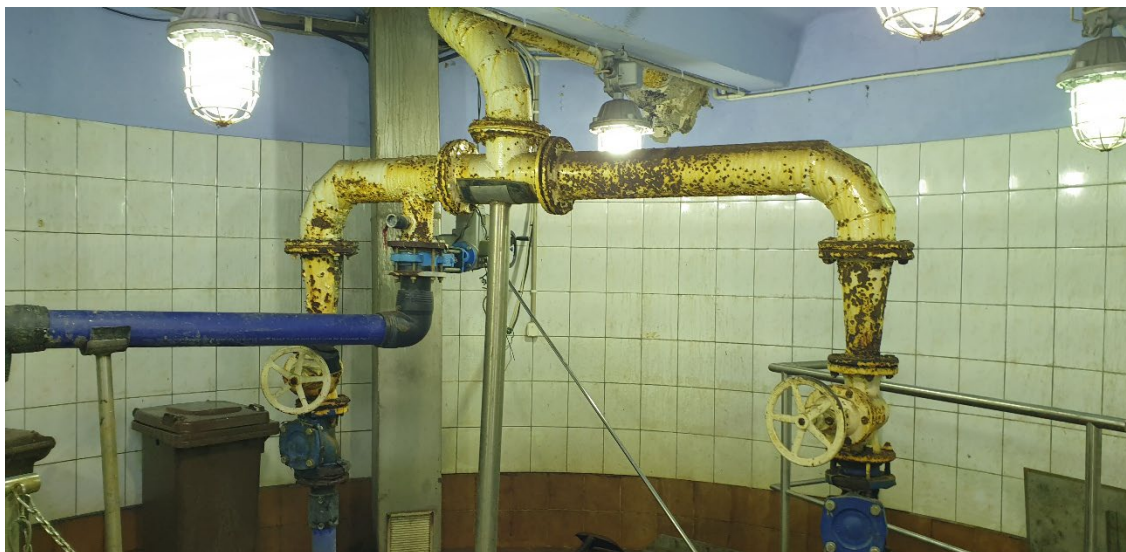
Fot. 14. Widok wnętrza przepompowni – poziom dolny, korozja armatury
