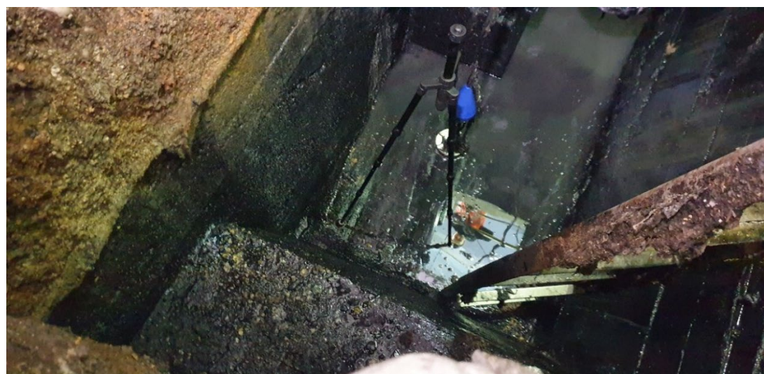
Fot. 19. Widok przegłębienia dna w komorze czerpalnej I
