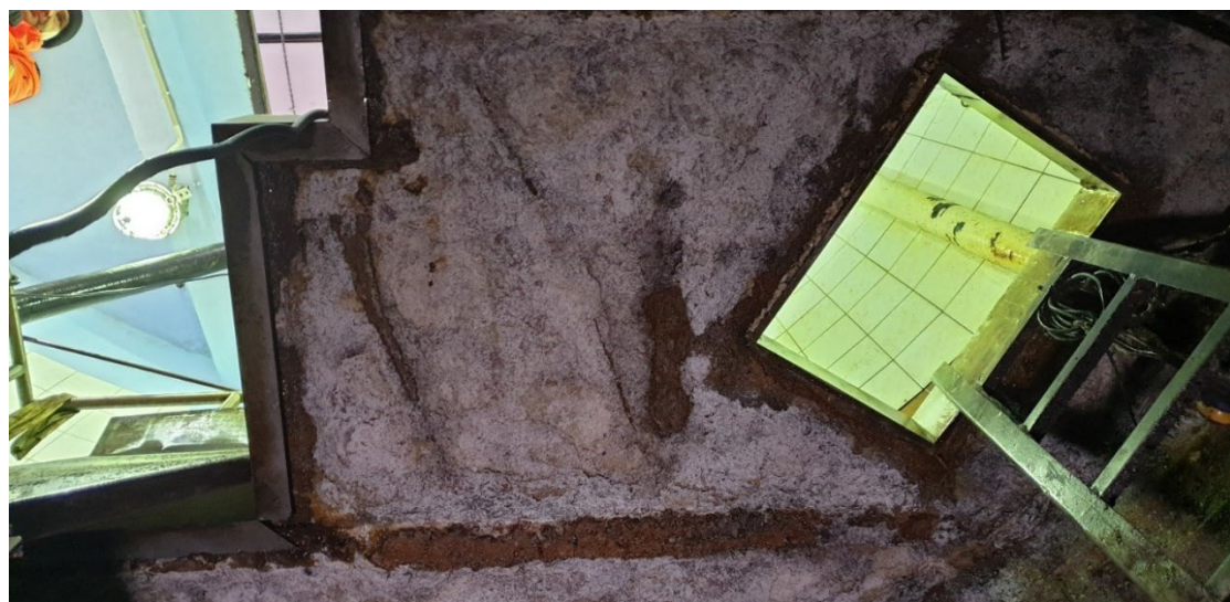
Fot. 28. Widok korozji betonu i elementów stalowych na stropie komory czepalnej I
