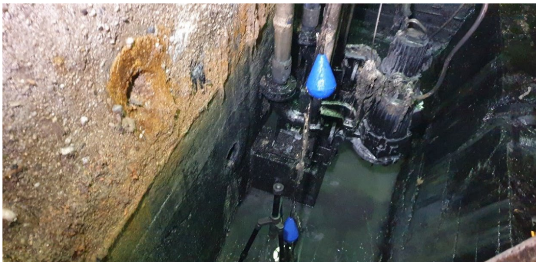
Fot. 20. Widok przegłębienia dna w komorze czepalnej I, korozja betonu na ścianie
