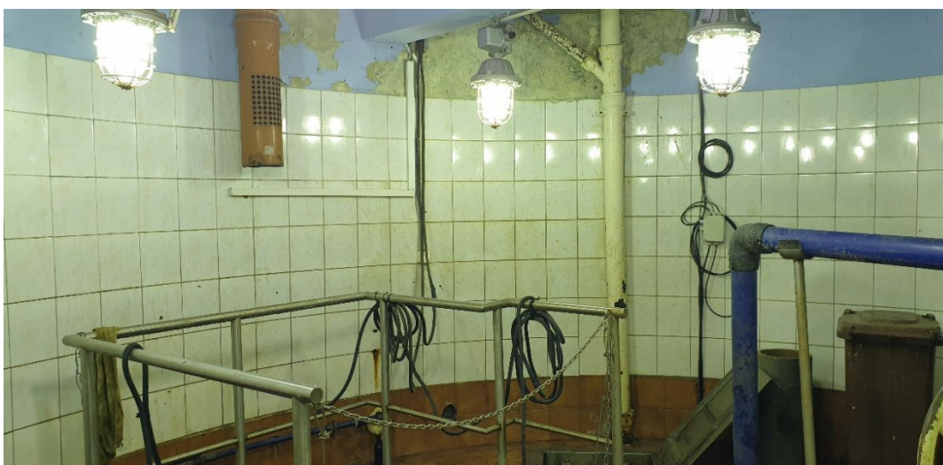
Fot. 9. Widok wnętrza przepompowni – poziom dolny, uszkodzenia powłoki malarskiej, odspojona okładzina ceramiczna
