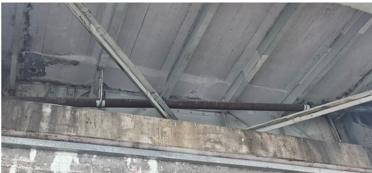
Fot. 41. Przebieg stalowego przewodu tłocznego na konstrukcji przyczółku mostu na Odrze
