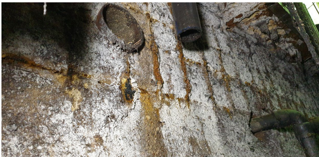
Fot. 22. Zaawansowana korozja otuliny betonowej i zbrojenia na ścianie dzielącej obie komory
