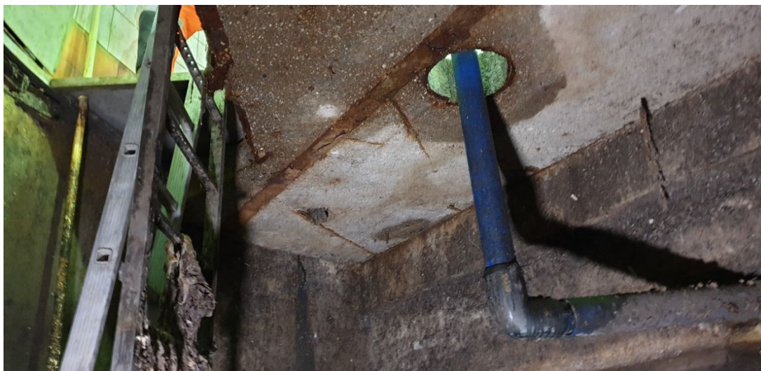
Fot. 30. Widok stropu w komorze czerpальной II, korozja betonu i belki stalowej
