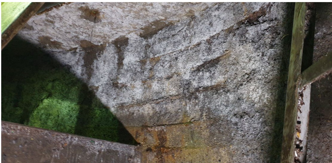
Fot. 23. Zaawansowana korozja otuliny betonowej i zbrojenia na ścianie komory
