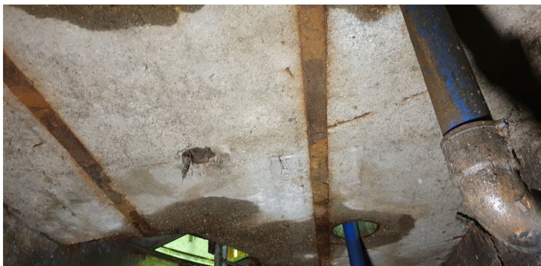
Fot. 31. Widok stropu w komorze czerpальной II, korozja betonu i belek stalowych
