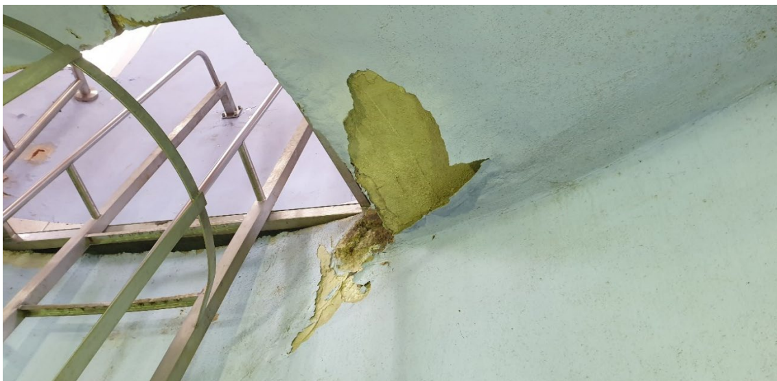
Fot. 11. Widok wnętrza przepompowni – poziom dolny, uszkodzenia powłoki malarskiej
