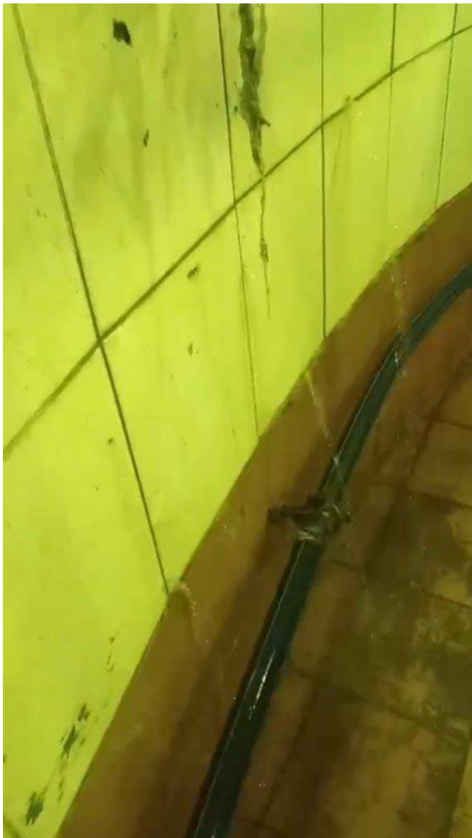
Fot. 38. Dynamiczne przecieki wody przez okładzinę ceramiczną na poziomie dolnym w trakcie powodzi (zdjęcie archiwalne PWIK w Głogowie z dnia 27.09.2024)
