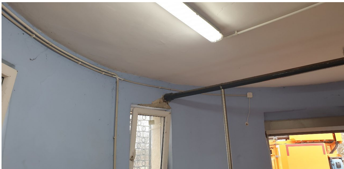
Fot. 5. Poziom górny – spękania i odspojenia tynku
