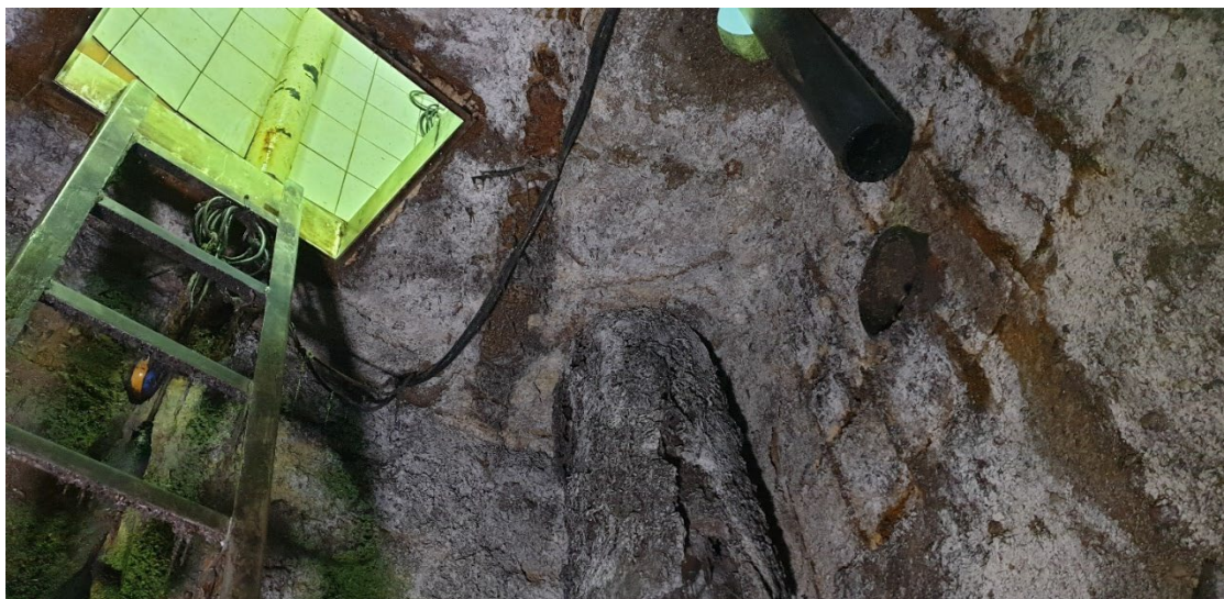
Fot. 26. Widok korozji betonu i elementów stalowych na stropie i ścianie komory czepalnej I
